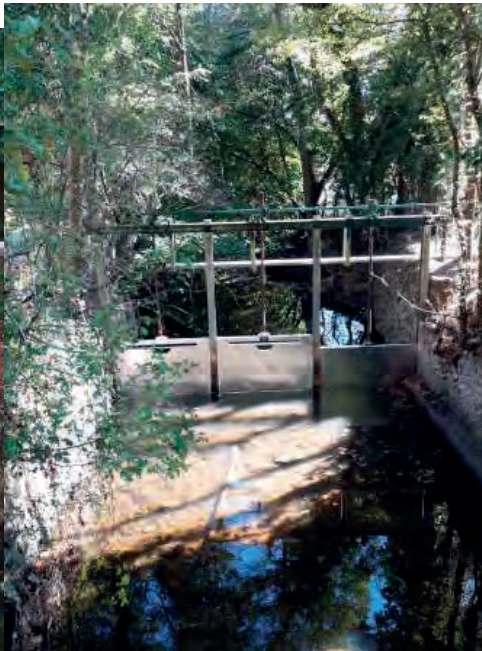
APRES TRAVAUX (Mise en eau non encore effectuée)
